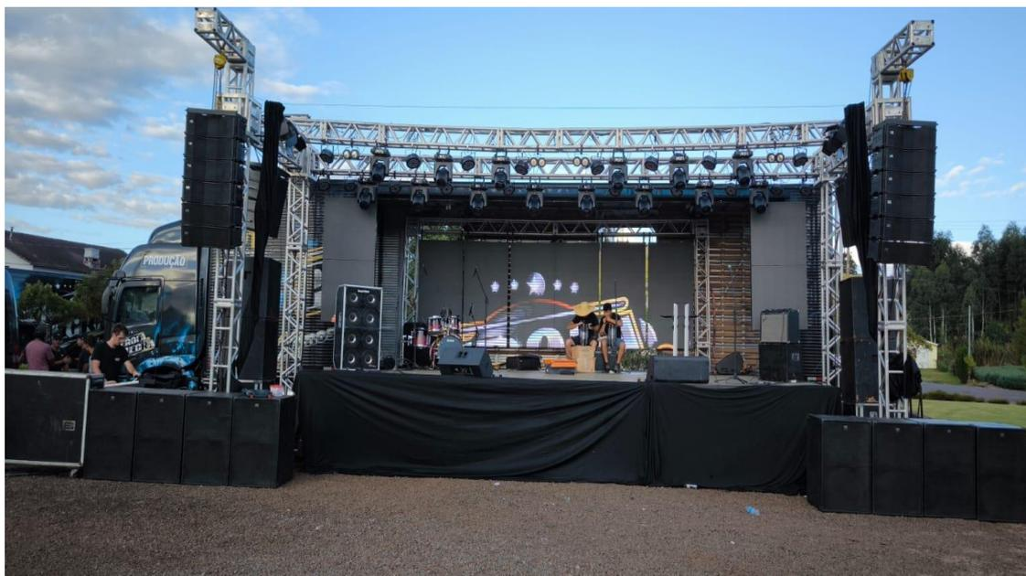
**Imagem 03** – Cada treliça dessas tem capacidade para 1ton cada uma. Essas treliças fazem a abertura do palco onde utiliza como cobertura apenas uma lona, não fazendo peso sobre as mesmas.
