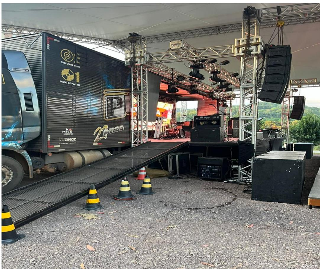
**Imagem 01** – Estrutura metálica externa – estrutura treliçada fixada conforme normas vigentes. Capacidade para 2 ton e está sendo usado uma capacidade menor que o limite para suportar os equipamentos.
