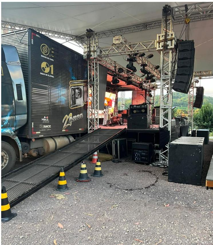
**Imagem 04** – Na imagem acima podemos ver a rampa utilizada para acesso ao palco e à carreta. A rampa possui um comprimento de 5m x 1m de largura.
